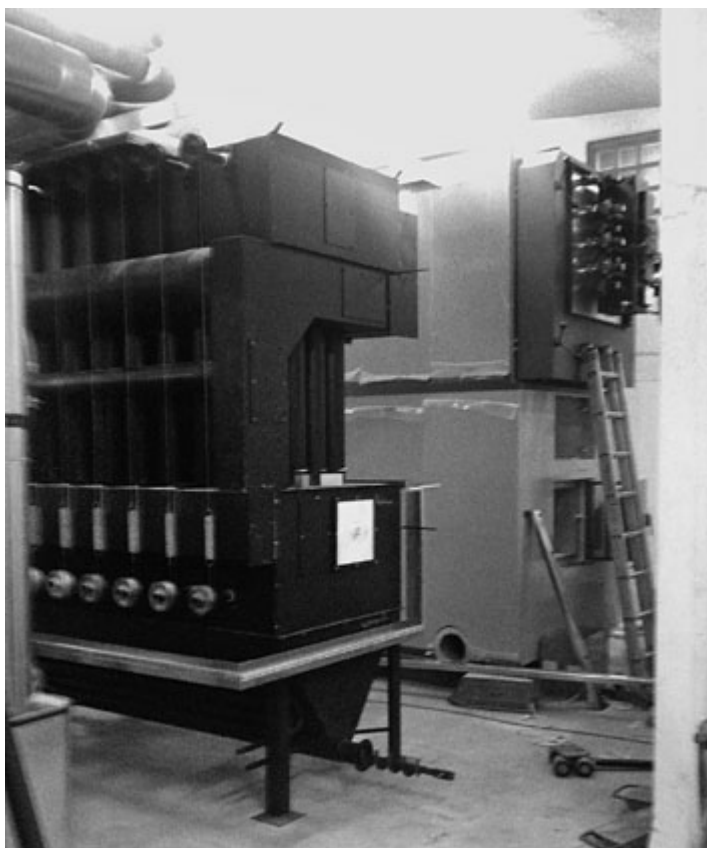
Elektrofilteranlage und Heizkessel im Bau
